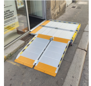
Accès PMR amovible
