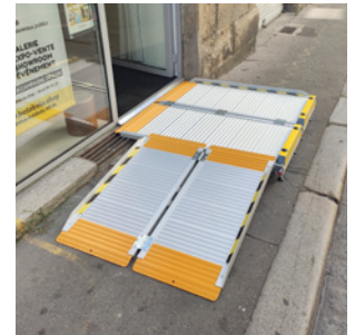
Accès PMR amovible
