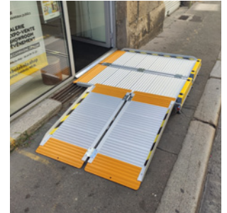
Accès PMR amovible
